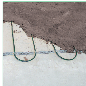
Толщина слоя раствора должна быть не менее 5–8 мм.
