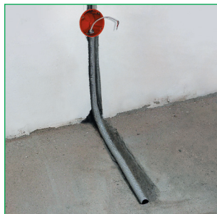
▲ При замене термодатчика не потребуется вскрывать пол
