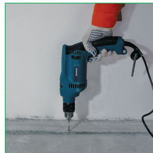
Просверлить отверстие
