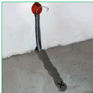
▲ Метка понадобится при укладке кабеля
