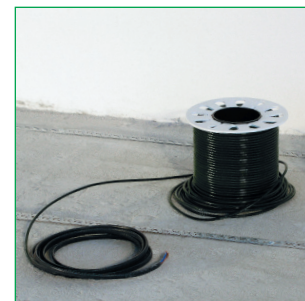
Монтажная лента уложена
