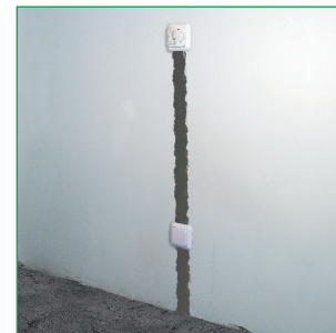
Штробы заделывают после заливки секций раствором и проверки отсутствия повреждений
